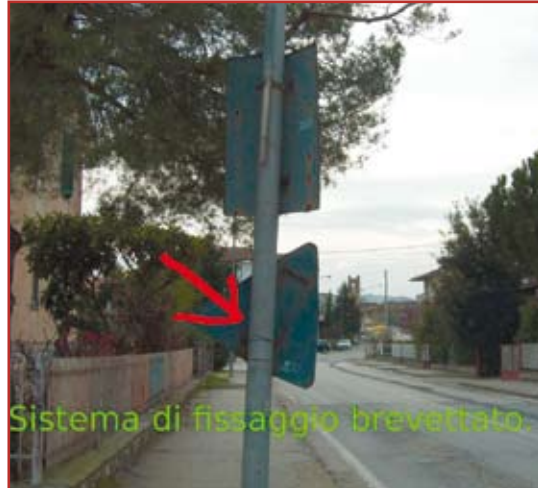
Davanti alla Scuola Media. "Sistema di fissaggio brevettato" (col filo di ferro).
